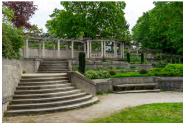
Terrassenanlage in der Tullnau (2023), GFA
